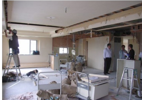
工事中：間仕切りを取り払い床、壁、天井、建具を一新。
