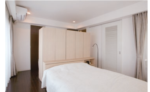
右の壁面に開口を設けて新設した引き戸。
