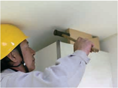
くさび 収納と天井のすき間が少ない場合は、くさびを打ち込んで収納を固定します。
