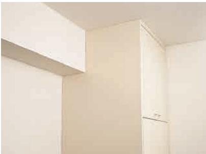
梁対応エンドパネル 特 梁下に収まる家具の上に浅い上置きを載せ、側面にパネルを張れば、きれいに仕上がります。
