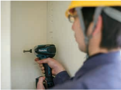
壁固定 背板が16mm厚のソリッド仕上げだから、収納本体をビスで壁に固定することができます。
